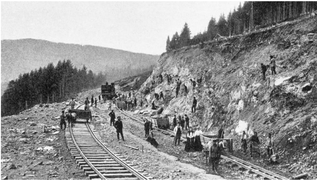
Construcción de un tramo del transiberiano que duro de 1891 a 1916
